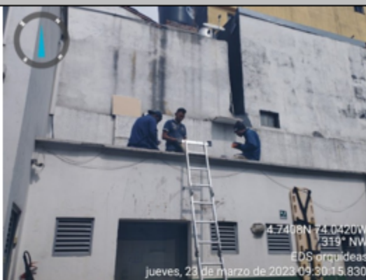
Foto 7. Impermeabilización de la terraza
